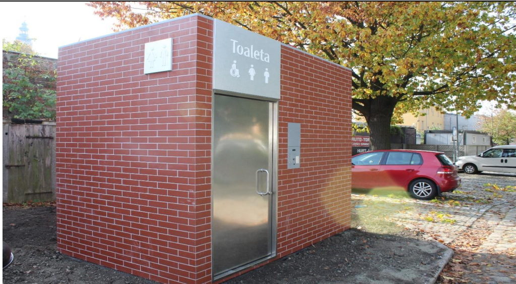
Zdjęcie 6. Jednostanowiskowa automatyczna toaleta publiczna.
