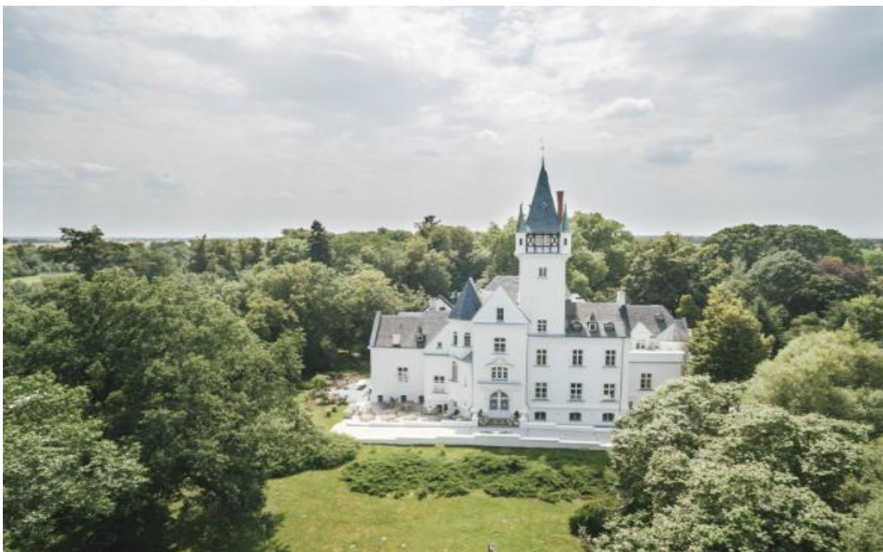
Zdjęcie 10 Pałac w Osowej Sieni
